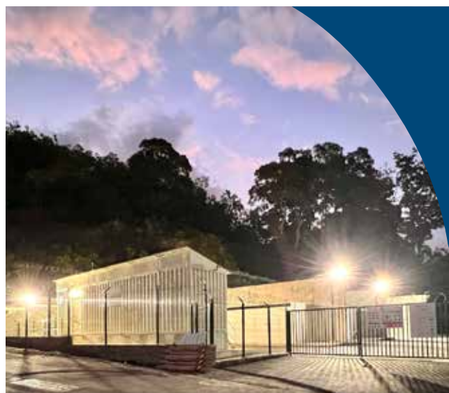
Stockage service réseau
